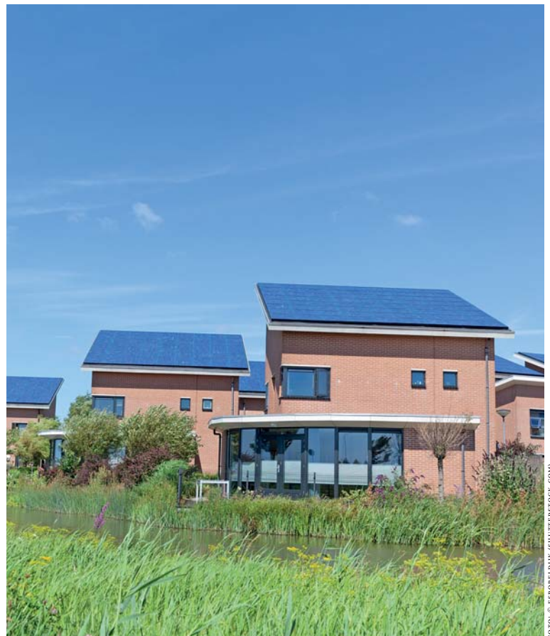
Erneuerbare Erzeuger geben zunehmend den Ton im Verteilnetz an.
